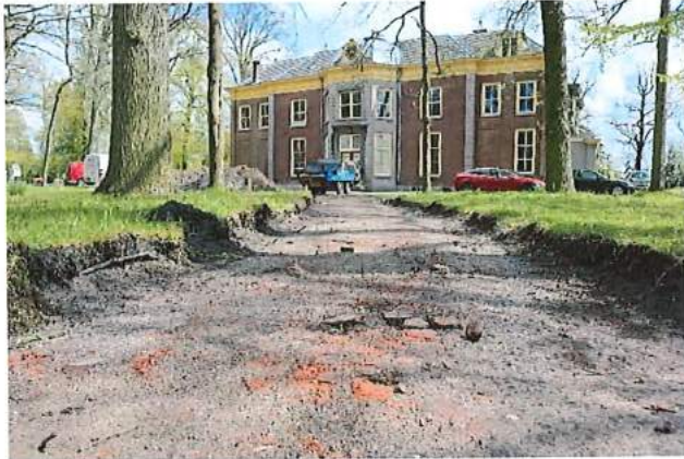
De fundering van de oude wandelpaden wordt blootgelegd
